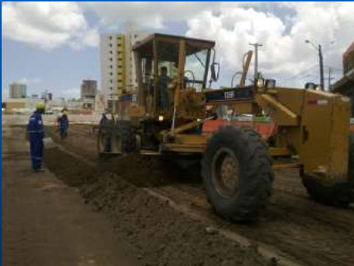
Execução da sub-base
