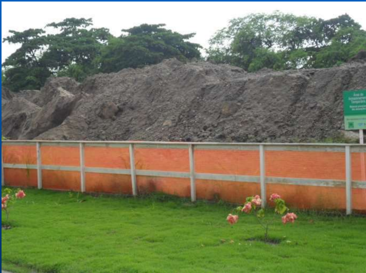
Pilha de solo das estacas
